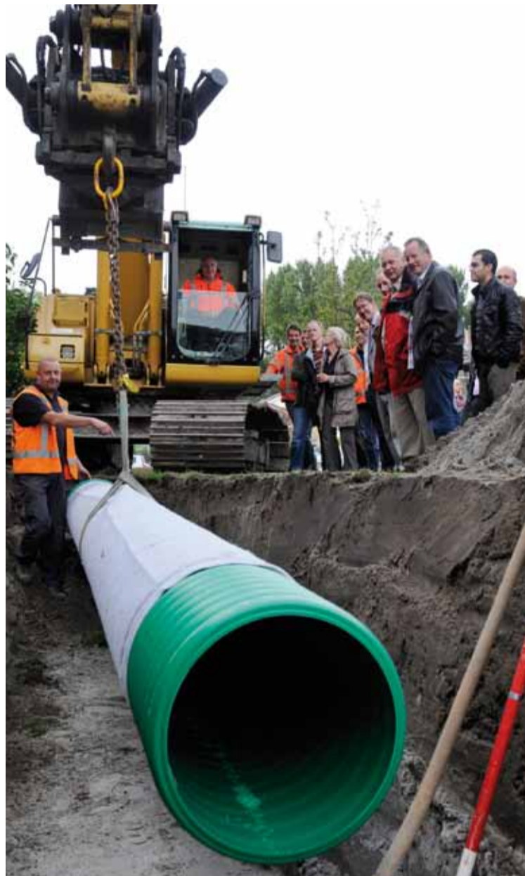
Wethouder Jan Nagengast plaatst de eerste buis.
