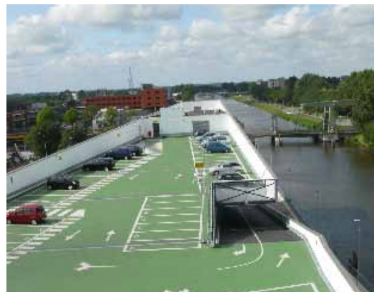
In de Spoorbuurt is men bevreesd voor een extra parkeerdruk in de wijk. De wethouder biedt daarom extra plaatsen voor parkeervergunningen aan in parkeergarage De Kazerne
