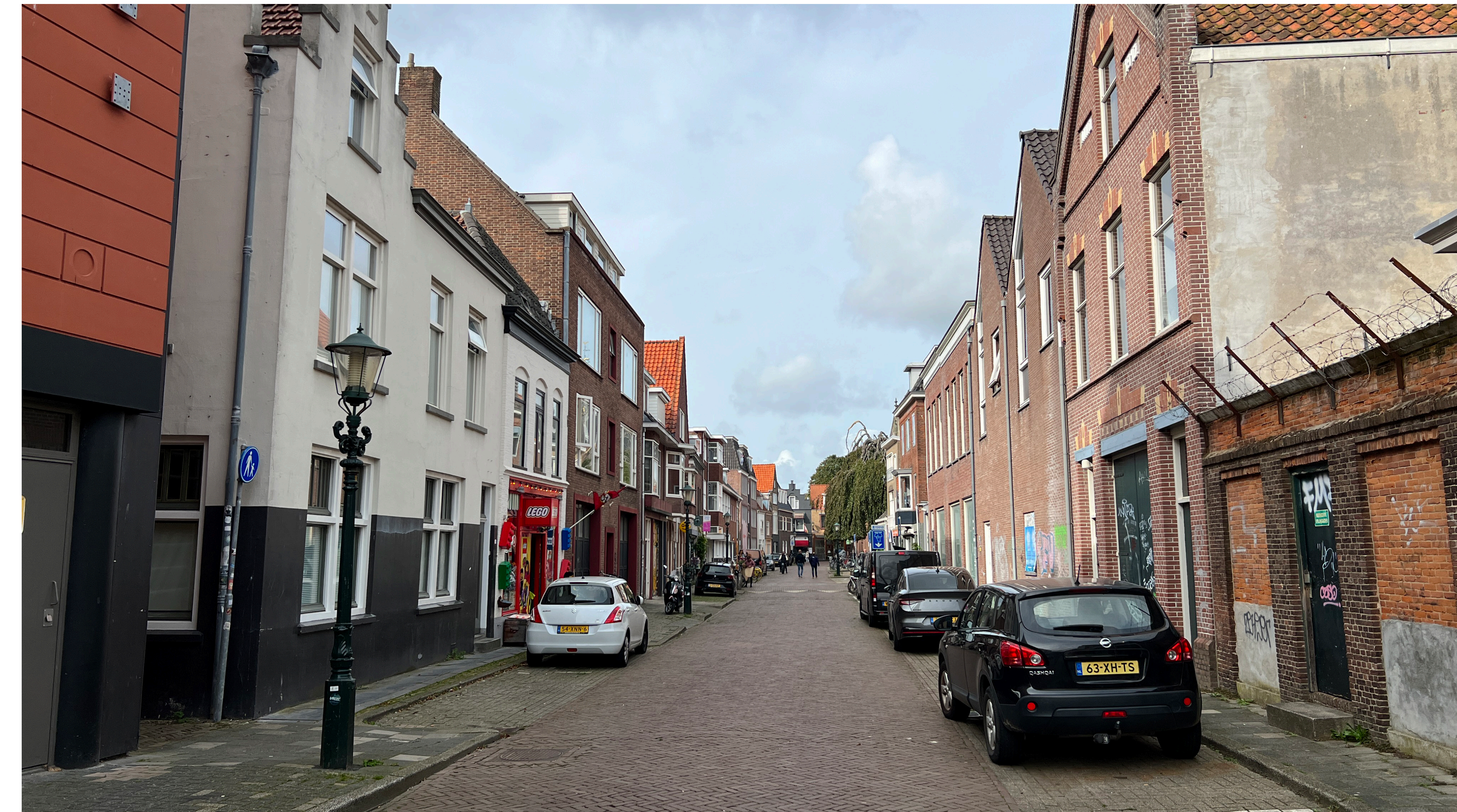
Zicht in westelijke richting ter hoogte van de Diggelaarssteeg
