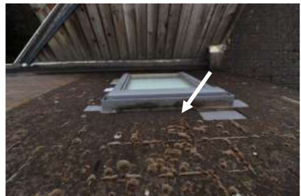
Dakleien om dakraam
