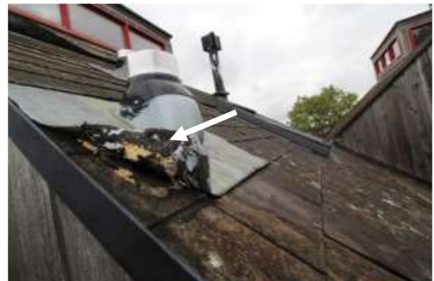
Lood om doorvoeren reinigen of meenemen in asbestverwijdering
