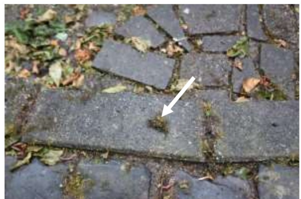
Asbesthoudend mos, in tuin op bestrating
