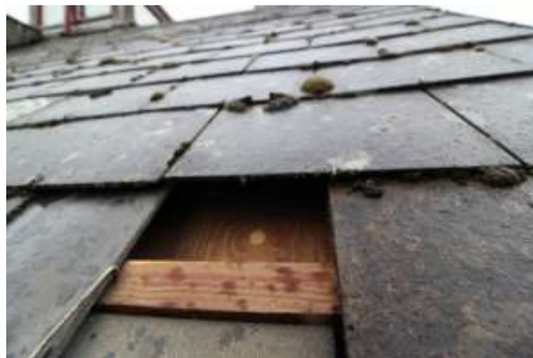
Foto 2 – Situatie dakbeschot onder dakleien
