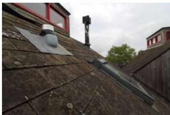
Foto 4 – Rookgasafvoeren, ventilatie en dakramen
