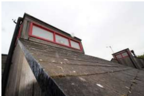
Foto 1 – Dakvlak voorzien van dakleien
