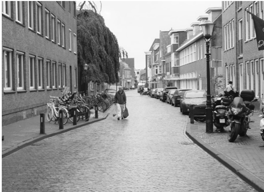
Een brede rijbaan, verhoogde trottoirs met trottoirband
