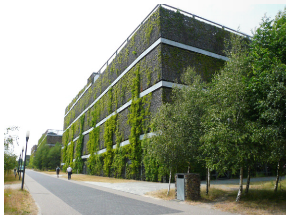
Referentie parkeergebouw, Hightech campus Eindhoven, ontwerp: CULD/Juurlink [+] Geluk
