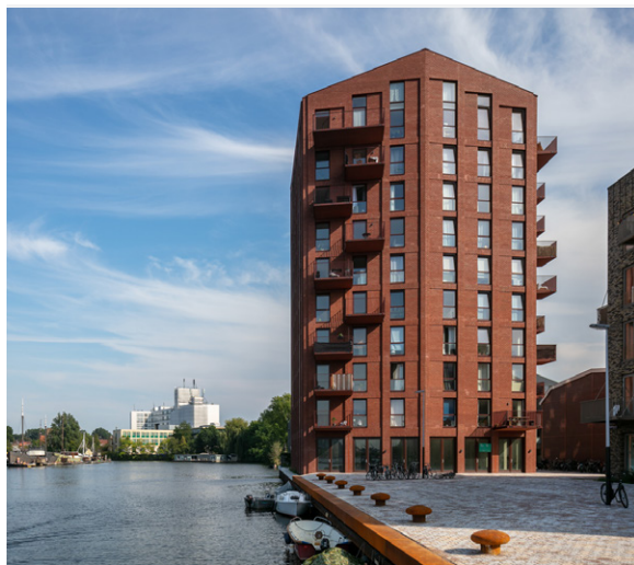
Referentie robuuste gebouwen, Loodsgebouw Amsterdam, ontwerp: Heren 5 Architecten
