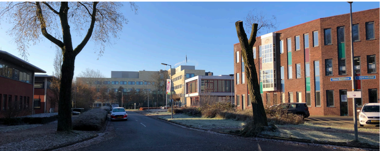
Werkgebouwen op het kantorenpark
