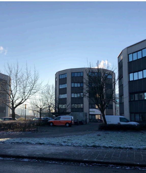
Tijdelijk wonen in bestaande kantoorpanden
