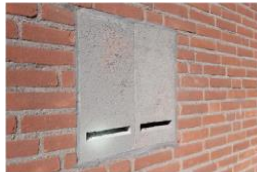
Vleermuiskast ingebouwd in de gevel
