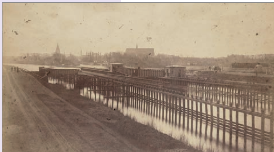
De aanleg van de spoorbrug over het Noordhollands Kanaal, circa 1865.
