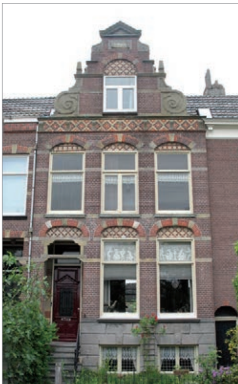
Metiusgracht 8, neorenaissance herenhuis met souterain, met siermetselwerk en gevelsteen 'Vondel' 1897 (foto Mark Koning).
