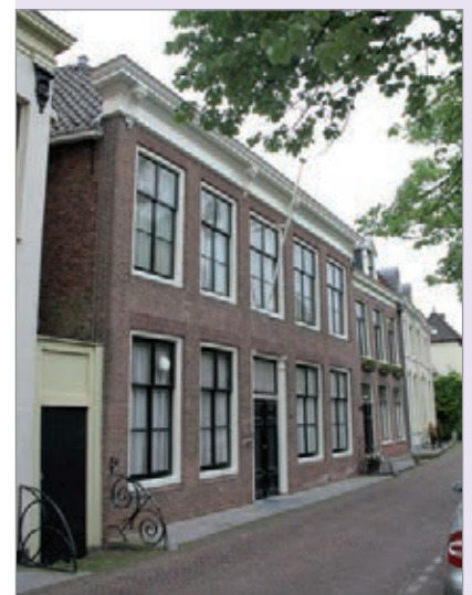
Dubbel woonhuis Oudegracht 297 met empire vensters en deur uit begin 19 de eeuw (foto Mark Koning).
