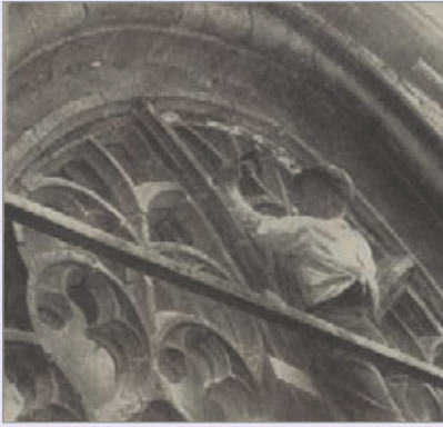
Restauratie van de kunststenen venstertraceringen van de Grote Kerk in 1930.
