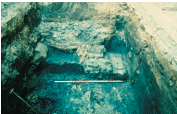
De zware spaarboog-fundering bij de Waag (Afdeling Monumentenzorg en Archeologie, Gemeente Alkmaar)
