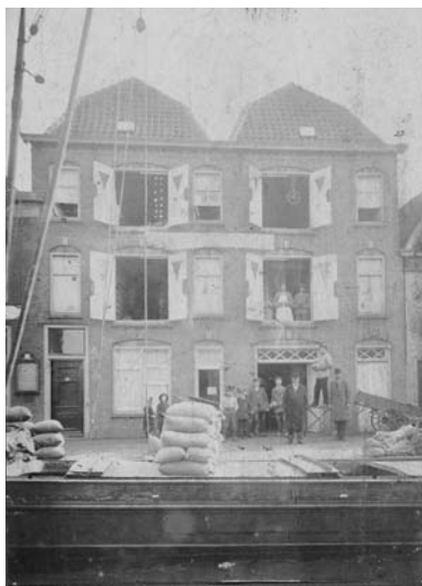
Kanaalkade met pakhuizen. Rechts wordt kaas geladen. Links worden vanaf een schip balen opgehesen (of andersom) (E.G. Verkade, ca. 1910; Collectie Regionaal Archief Alkmaar)
