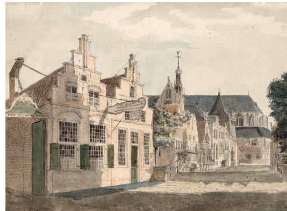
Logement de Toelast in de Koorstraat, met de ruitstalling en brug over de Laat. In de verte zien we de klokkentoren en koor van de Grote Kerk (J.A. Crescent, 1804) [Collectie Regionaal Archief Alkmaar]
