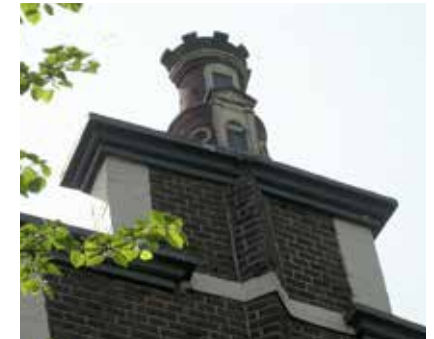
Nog altijd wordt de gevel van voormalig hotel De Burg (nu dierenwinkel Pets Place) bekrond met een burcht [foto: Harry de Raad]
