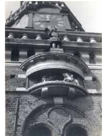
Detail van de oostgevel van de Waag met klok, klaroemblazer en ruitertjes (A.G. van Agtmaal, ca. 1935) [Collectie Regionaal Archief Alkmaar]
