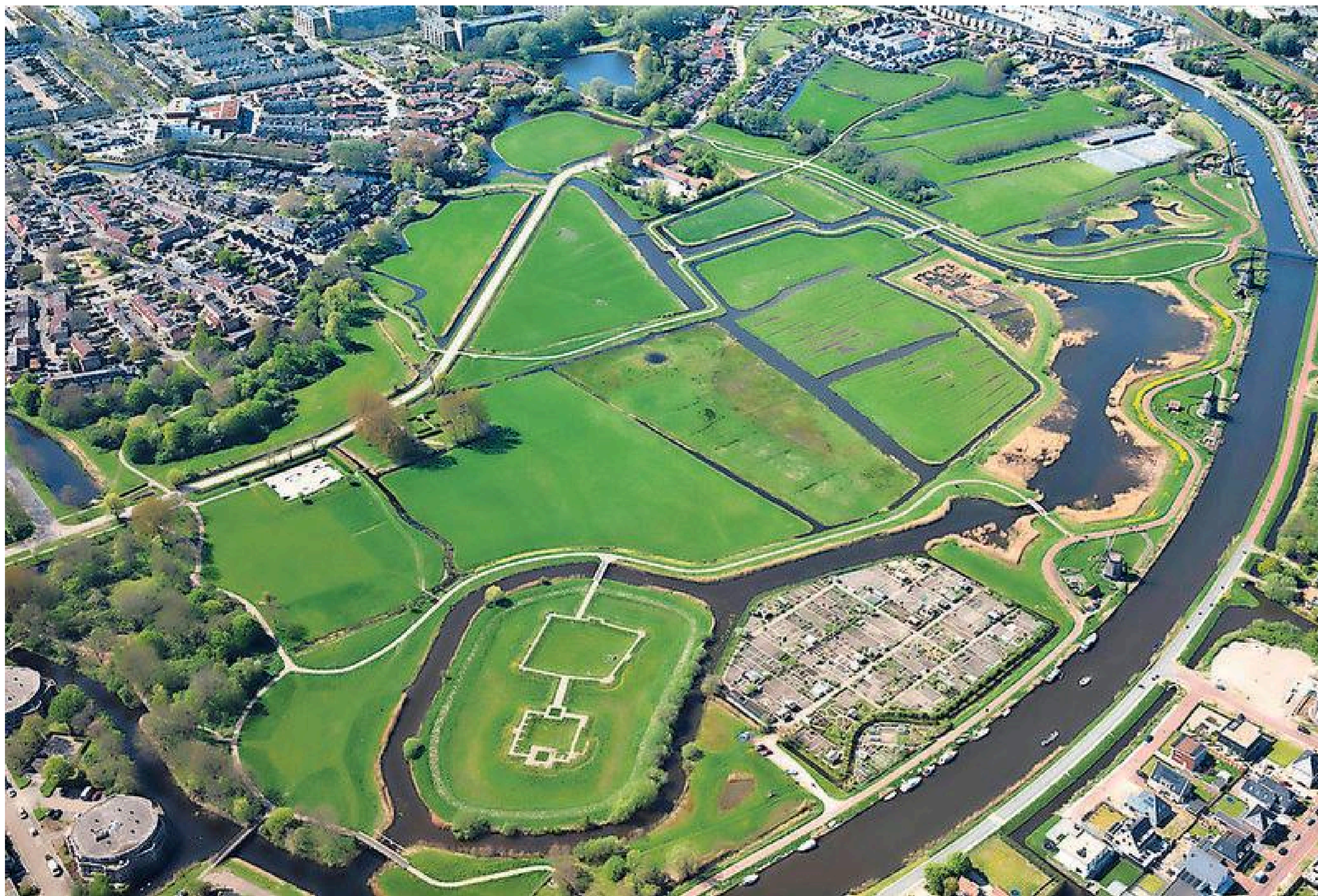
Luchtfoto van de Oudorperhout. Midden onder zijn de fundamenteën van de Nijenburg met voetpaden aangegeven. Het terrein met de fundamenteën van de Middelburg is links van de Munnikenweg, op de foto bovenin.
