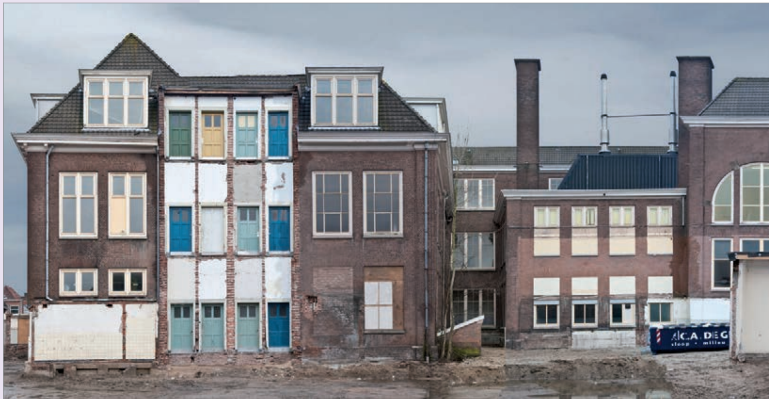
Achtergevel na afbraak van de vleugel uit 1956. Foto J. Elsinga.
