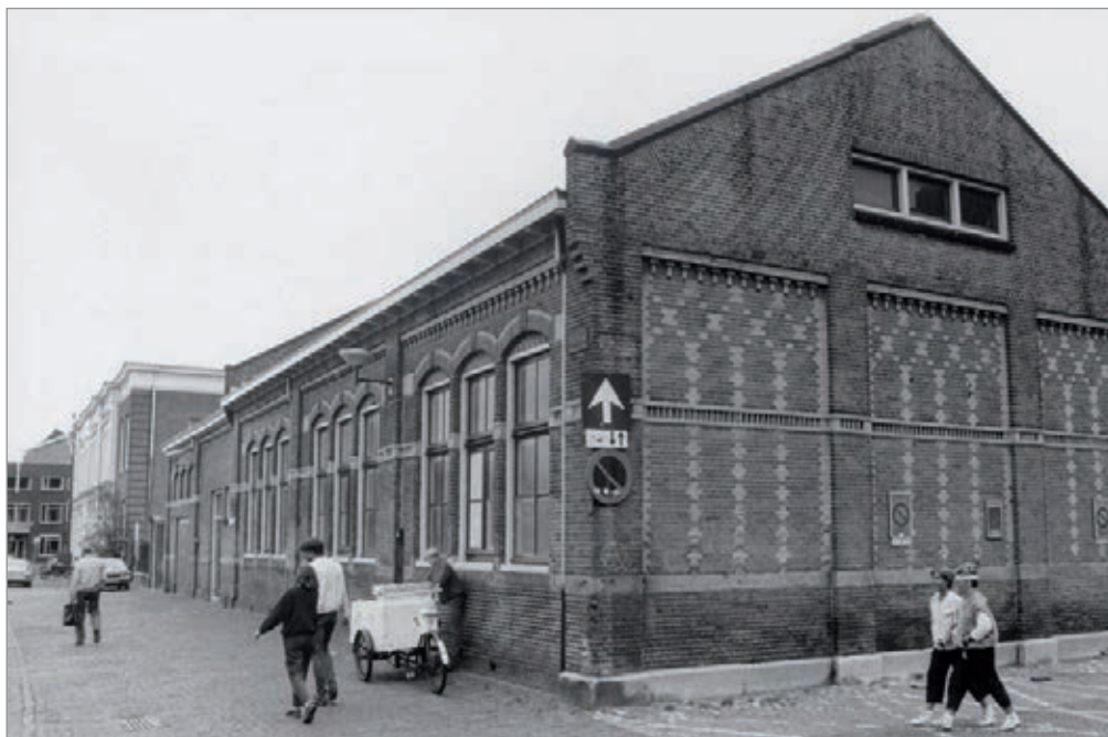
Afb. 21. De voormalige armenschool gezien vanaf de hoek Gedempte Nieuwesloot en de Schoolstraat (nu Sint Sebastiaanstraat). Foto: B. Ulrich, 1983.
