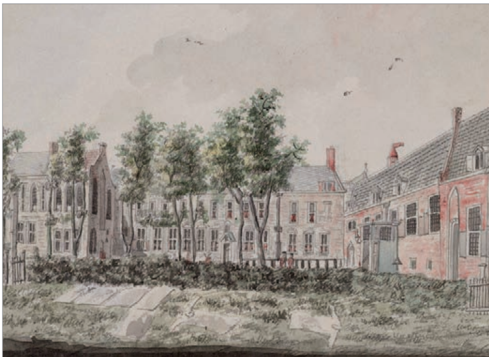
Afb. 5. De binnenplaats van het Burgerwees- en Huisarmenhuys naar het zuiden gezien. Links de voormalige kloosterkapel. Tekening door J.A. Crescent, 1789.
