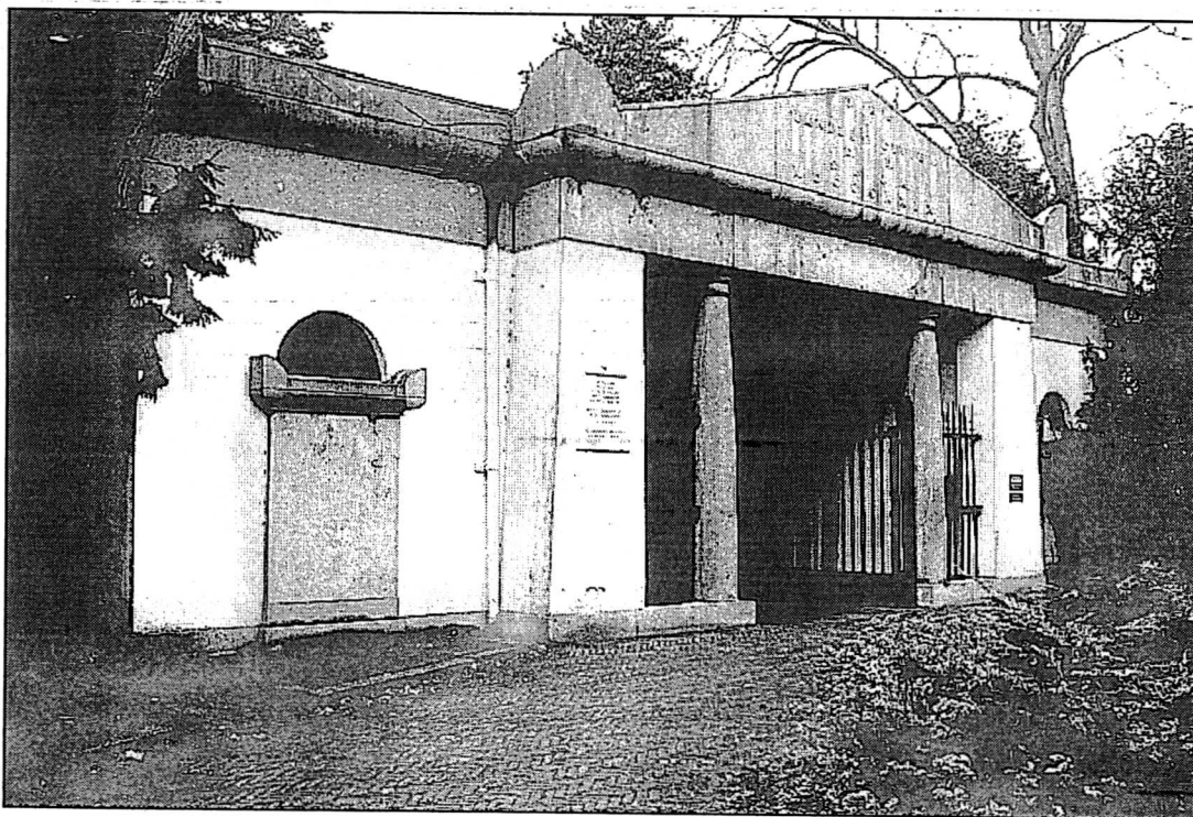
Vooraanzicht van de ingangspartij van het poortgebouw
