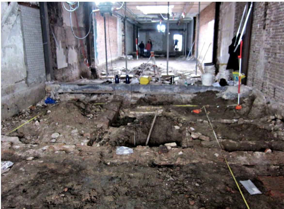
Afb.15 Overzicht uit het noorden: vooraan muur 3A, rechts erachter waterkelder 4/5C en linksachter kelder 4A
