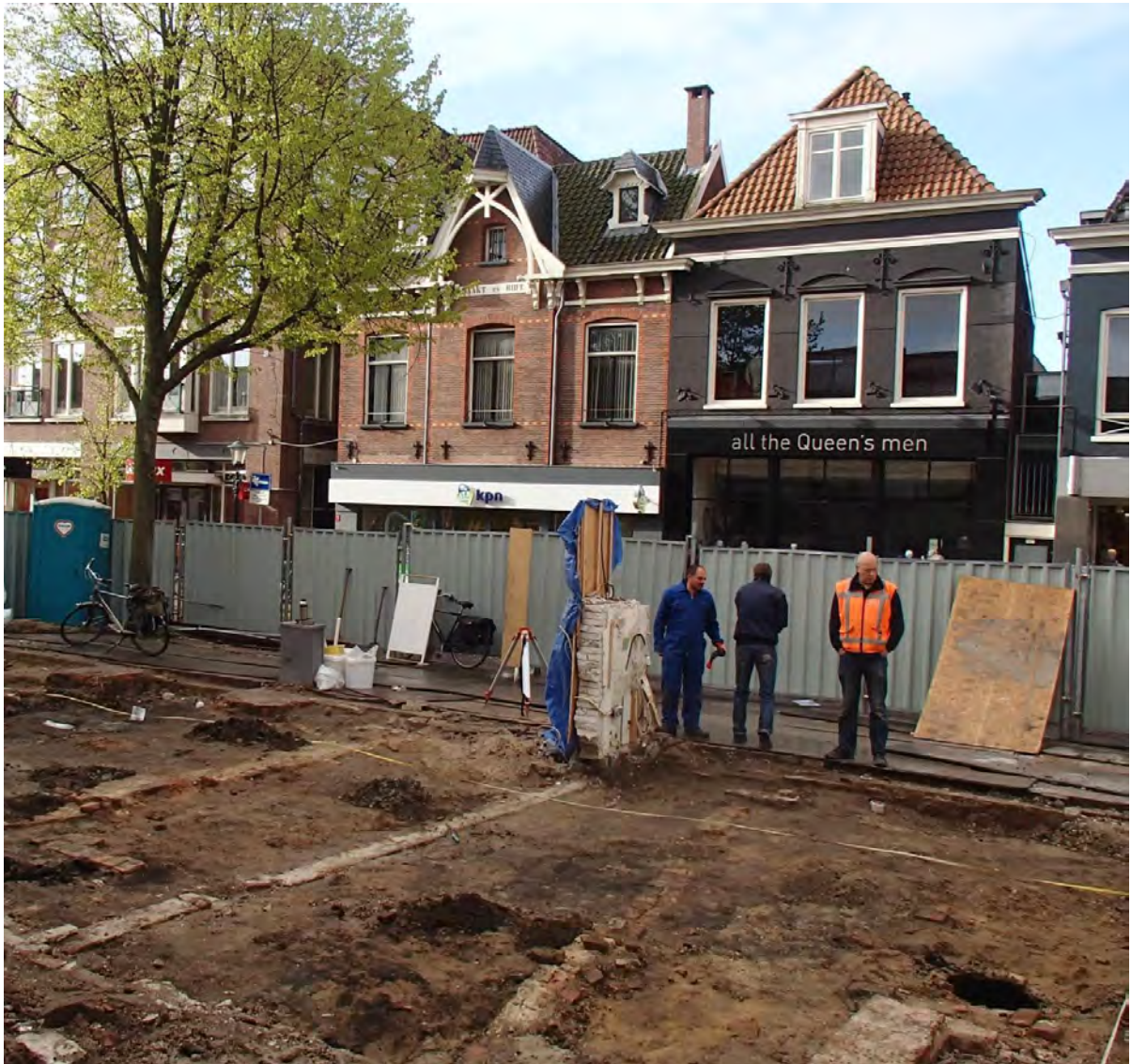
Afb.1 Het eerste vlak, op 10 cm onder de verwijderde betonvloer, is met de hand aangelegd.
