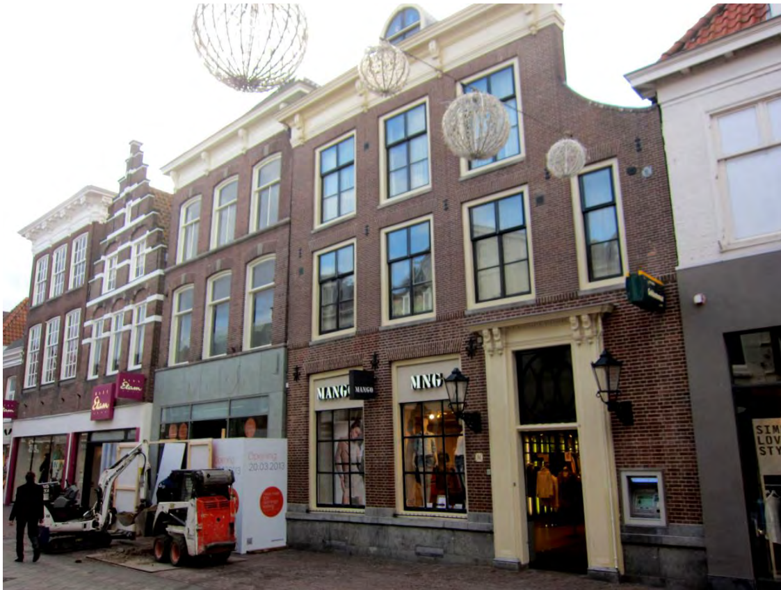
Afb.1 Langestraat 49 tijdens de verbouwing in 2013.
