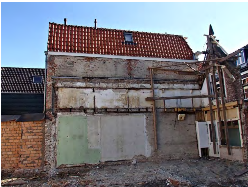
Afb.7 Het afgebroken pand Schoutenstraat 36 tijdens de opgraving, de voorgevel gestut
