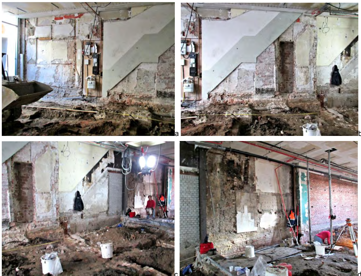
Afb.35a-d De oostelijke zijmuur van het hoofdhuis (a-b): de kern van opstaand muurwerk hoort nog bij de fundering rechts (3A); met sporen van de 20 ste -eeuwse trap van het hoofdhuis. De oostelijke zijmuur van het achterhuis (c-d): opgaand muurwerk 3C met uit 1879 de resten van de trap van het achterhuis en schouw 6B.
