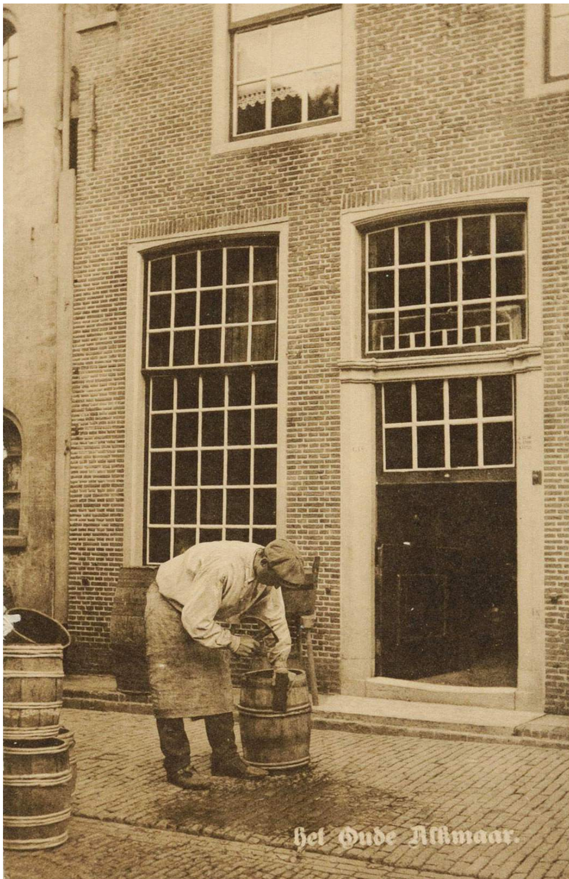
Een kuiperij aan de Achterdam. Leuk detail bij de ingang van het pand: een onderdeur en een opschuifbare bovendeur
