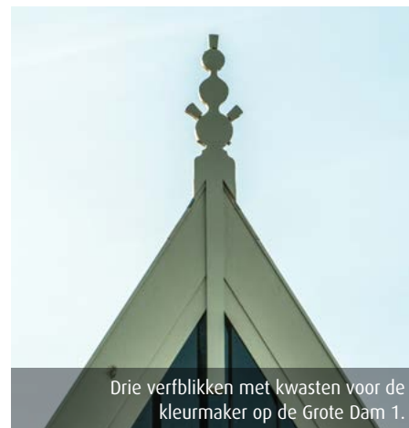
Een torenmakelaar met een nog relatief lange staart. Bij de meeste makelaars is de oorspronkelijke constructieve functie geheel verloren gegaan.
