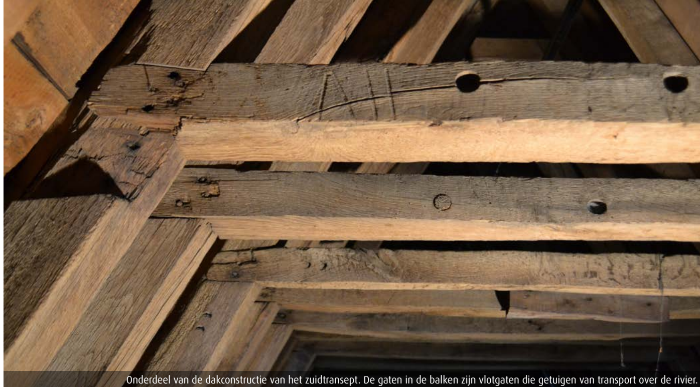
Onderdeel van de dakconstructie van het zuidtransept. De gaten in de balken zijn vlotgaten die getuigen van transport over de rivier.
