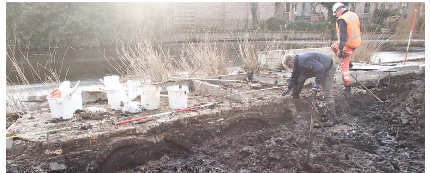
Bakstenen-fundering van het negentiende-eeuwse huis op poeren en grondbogen (bij het opschonen van de fundering is het terrein al behoorlijk vertrapt...).
