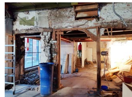
Het interieur van de voormalige winkel, met een merkwaardige houtconstructie die de muur van het tweede huis achter Verdrunkenoord 121 opvangt. Boven de doorgang een oude ontlastingsboog in het metselwerk van circa 1600.
