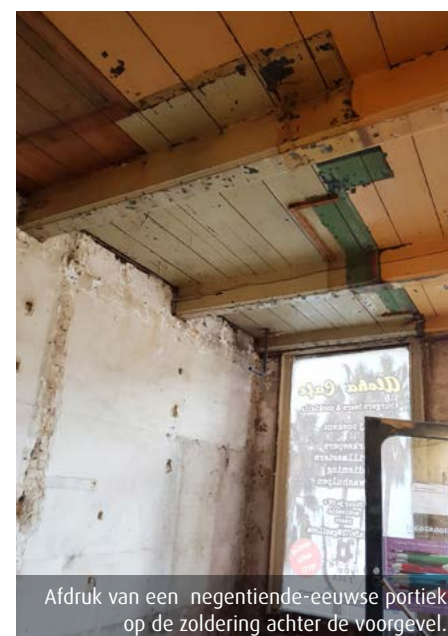
Balklaag met console van het tweede pand, circa 1575/1625 (bij de westmuur).
