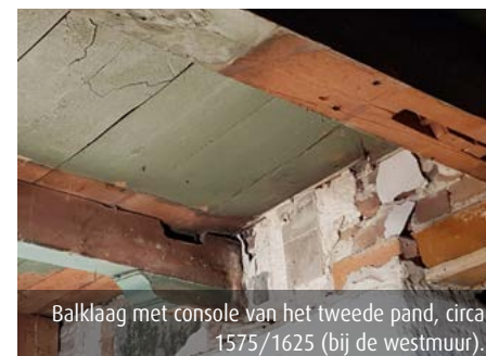
Het interieur van de voormalige winkel, met een merkwaardige houtconstructie die de muur van het tweede huis achter Verdrunkenoord 121 opvangt. Boven de doorgang een oude ontlastingsboog in het metselwerk van circa 1600.
