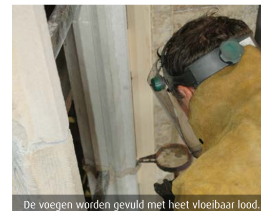
Het lood wordt ter plekke op de steiger gesmolten.
