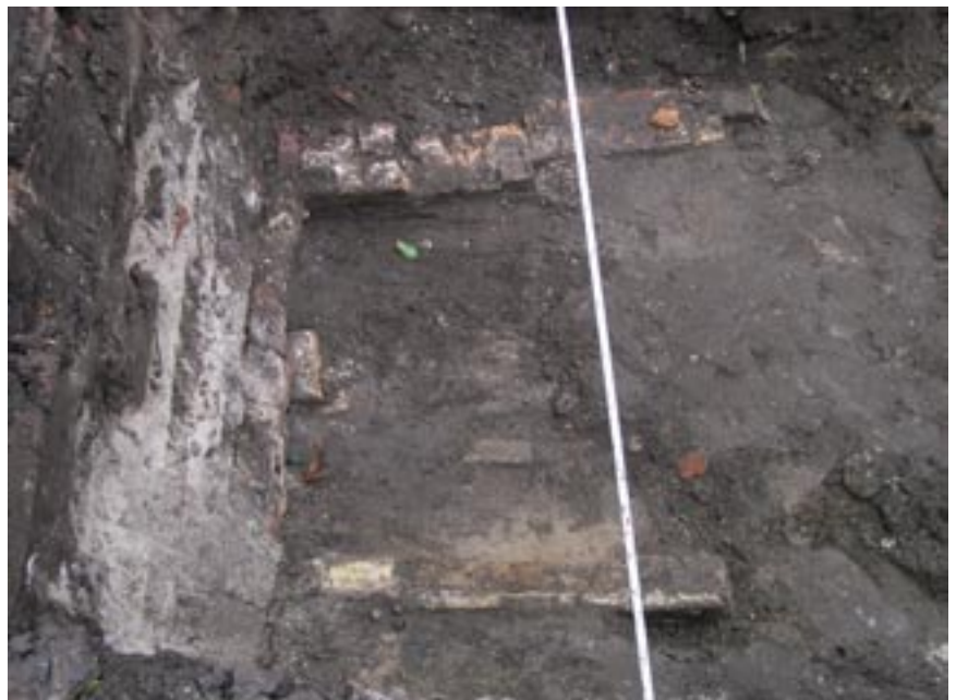
Fundering onder schoolmuur
