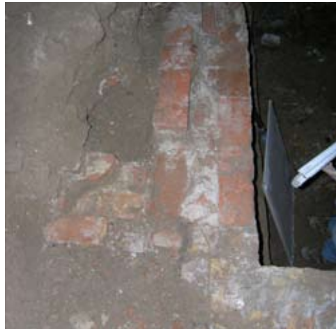
Afb.56 Bovenaanzicht van keldermuur 1D, vanuit het zuiden, met linksonder de keldermuur van huis 2B (de kelder is gedempt) en rechtsonder de nieuwe keldermuur 4F
