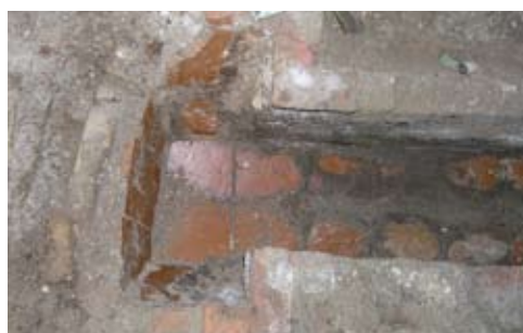
Afb.58-59 Riool 5C, met het privaat van bin-nen uit gebouwd in de achtergevel van Langestraat 3B
