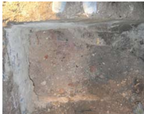
Afb. 70-71 Fundering van een achterhuis met ondiepe kelder (4C), wat onpraktisch gebouwd om beerput 3B heen die kennelijk niet buiten gebruik gesteld kon worden, gezien vanuit het westen
