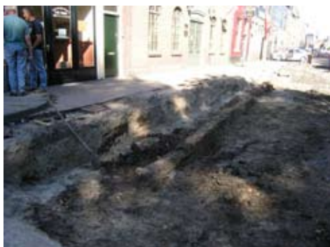
Afb. 76-77. Funderingen van huizen, gebouwd rond 1580 en afgebroken voor de aanleg van de Wageweg in 1640/41
