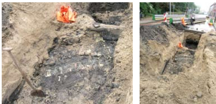
Afb. 30-31. In de smalle rioolsleuf werkput 3 komt in 2008 de fundering van de zijkant van de toren van de Wortelpoort te voorschijn
