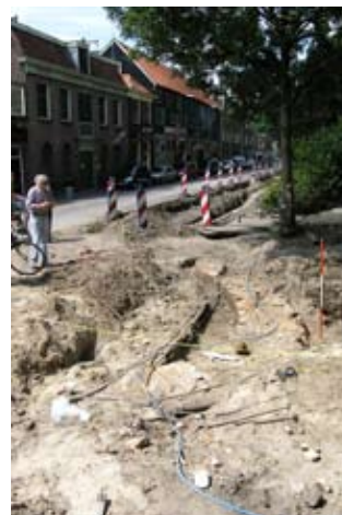
Afb. 36-39. Onderzoek van de Rode Toren. Afb. 38 toont een beschoeiing aan de buitenzijde van de toren, afb. 39 het V-vormige fundament aan de zuidkant
