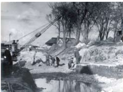
Afb. 5-8. Het afgraven van de Wageweg in 1951, waarbij van de muur onder het wegdek een heel stuk is afgebroken en de muur langs het Victoriepark is vrijgelegd (Regionaal Archief Alkmaar)
