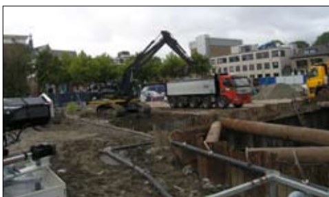
Afb. 19-20 Werkput 1 lag direct ten zuiden van de teerputsanering. De teerput was vlak tevoren binnen een tijdelijke damwand diep uitgegraven. Werkput 1 was tevens een rioleringsleuf. Er werden een vlak en een profiel aangelegd
