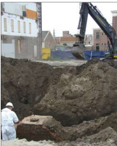
Afb. 21 In werkput 2 werd de stadsmuur opgezocht
