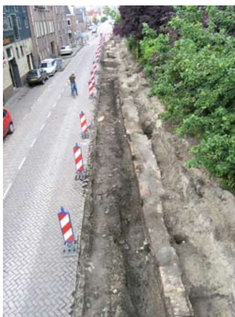
Afb. 9-10. De ontdekking van een zwaar fundament bleek de herontdekking van ruim 100 meter stadsmuur
