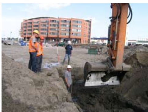
Afb. 1-2 Aanleg van de sleuf
