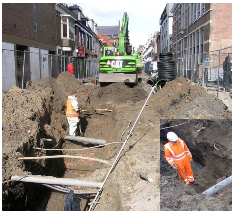
Afb.34 Het graafwerk stuit op bruggehoofd 6B. Rechts de open plek waar kort tevoren Hollandia de overzijde van de brug heeft opgegraven
