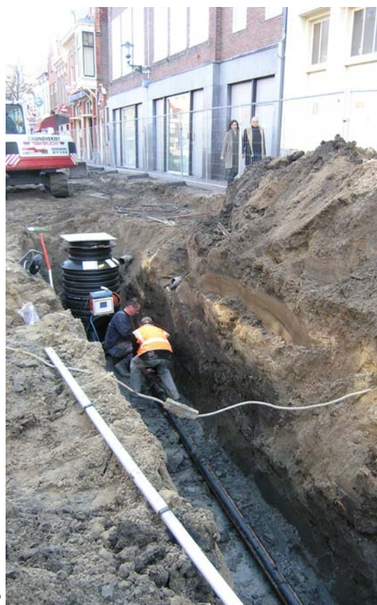
Afb.2-3 Ontgraving van de sleuf met allerlei hindernissen; het plaatsen van de mantelbuizen onderin de sleuf
