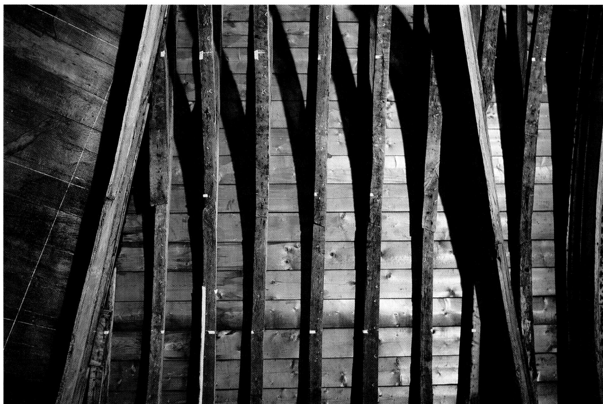
Boven: de kapconstructie, na demontage van de twee vakken met De Hel. Onder: de kasporen met de resten en gaten van het oorspronkelijke beschot tussen soortgelijke herinneringen aan 19 de - en 20 ste -eeuwse afdekkingen [foto's: J. Elsinga]
