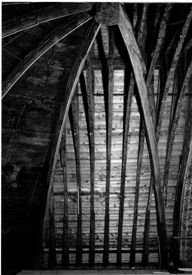
Boven: de kapconstructie, na demontage van de twee vakken met De Hel. Onder: de kasporen met de resten en gaten van het oorspronkelijke beschot tussen soortgelijke herinneringen aan 19 de - en 20 ste -eeuwse afdekkingen [foto's: J. Elsinga]
