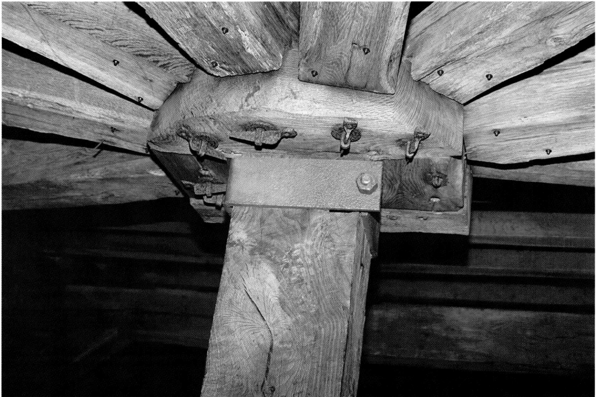
Kraag om de koningstijl. De dekbalken van de topspanten daaraan met spiebouten verbonden (oranjegeverfde klem is 20 ste -eeuws) [foto: J. Elsinga]
