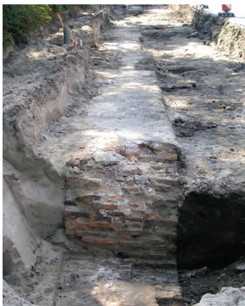
De ontdekking van 105 meter van de walmuur onder de Wageweg in 2006. Funderingshout ervan is naderhand dendrochronologisch gedateerd in het voorjaar van 1537. De walmuur staat iets achterover om tegendruk te geven aan de wal.
