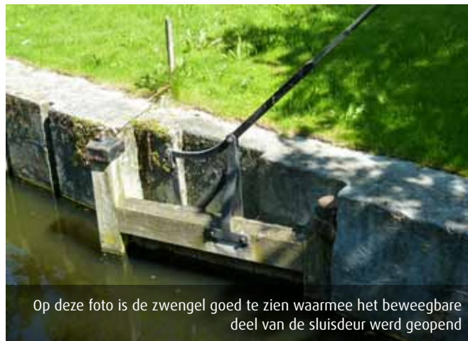
Op deze foto zijn goed de staalplaten te zien die later over de eiken sluisdeuren zijn geplaatst omdat het (niet voldoende onderhouden) hout het water niet meer tegenhield.
