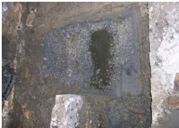
Links: de schelpenlaag in de kelder
