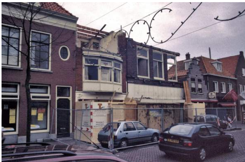
Afb.2 Sloop van Laat 212 en 210/208 begin 1998
