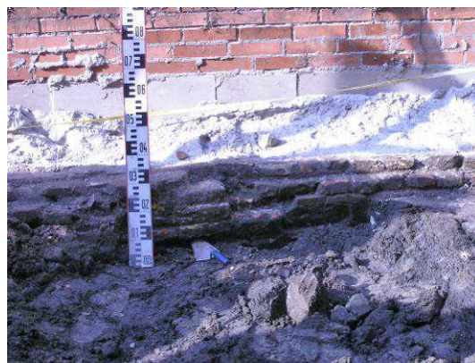
Afb.39 Restant van vervanging 4E van verzakte achtergevel (in de hoek)
