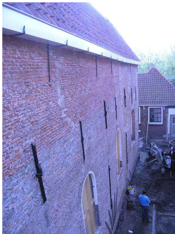
Afb.46a-b, 47 Details van de zuidgevel van de synagoge, gemetseld van hergebruikte baksteen
