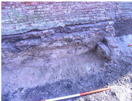
Afb.39 Restant van vervanging 4E van verzakte achtergevel (in de hoek)
