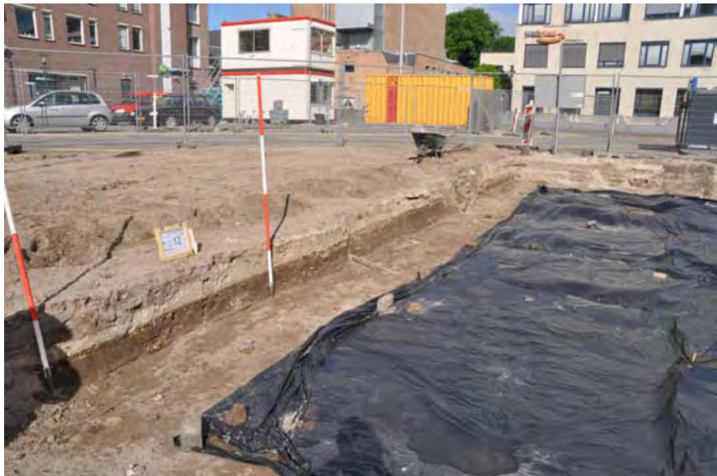
Afbeelding. 4.48 De wanden van de opgravingswerkputten zijn recht afgestoken als profielen
