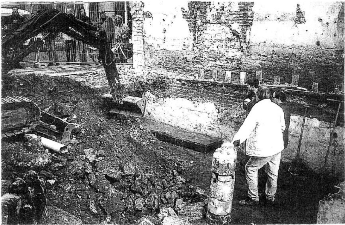
Boven: 12D, de kelder van pand nr. 113 wordt uitgegraven. Op de voorgrond een bakstenen gepleisterde zuil
