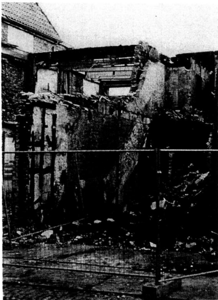
Links: Langestraat 113 en - 115/117 tijdens de sloop.
